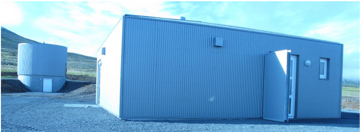
Mynd 2: Dæmigert stjórnhús og jöfnunartankur í hitaveitu RARIK (frá byggingu samskonar mannvirkja vegna hitaveitu RARIK Blönduós/Skagaströnd – myndin tekin 2016)
