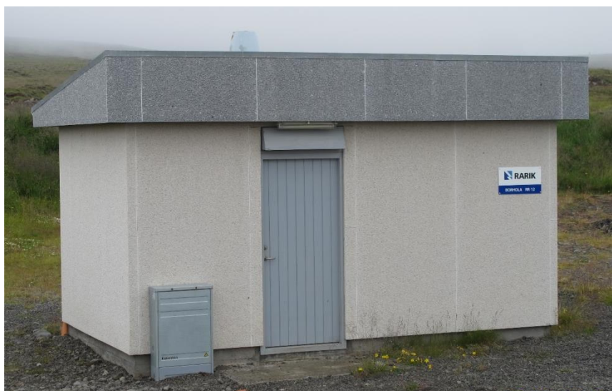
Mynd 4: Dæmigerður frágangur á borholu í hitaveitu RARIK (Blönduósi/Skagaströnd, ljósmynd tekin 2015)
