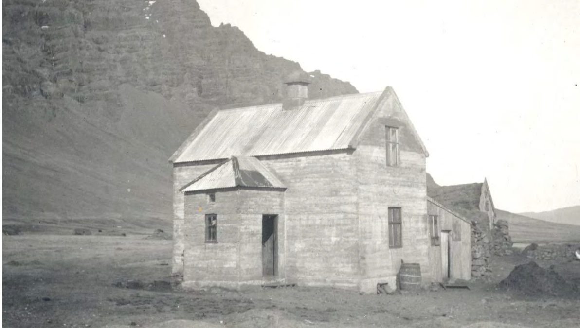
Mynd 8. Breiðabólstaður 1, steinsteypt íbúðarhús reist 1934 á grunni eldri bæjarhúsa. Ljósmynd í vörslu Héraðsskjalasafns A-Skaftafellssýslu (Héra-Skaft.1994-1.62).
