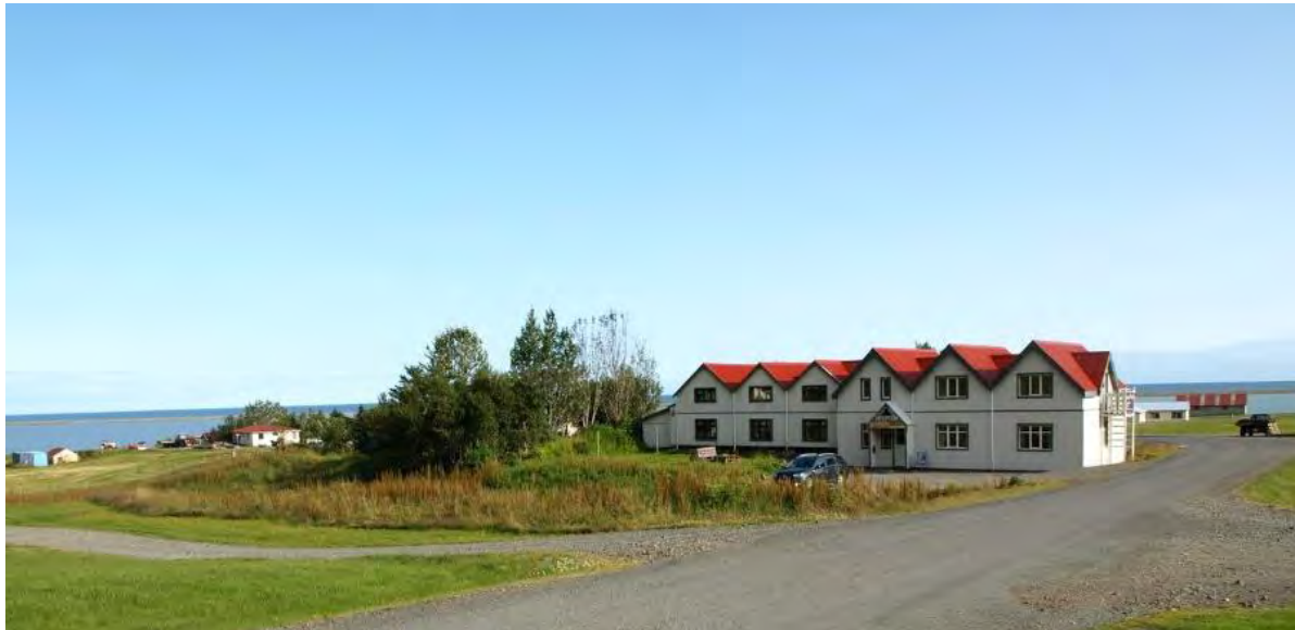
Mynd 15. Hali 2019, horft til suðurs. Fjós og hlaða sem stóðu vestan við íbúðarhúsið hafa vikið fyrir nýrri byggingu, sem er í sama byggingastíl og bærinn frá 1934. Ljós. SGB, ágúst 2019.
