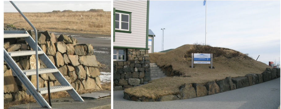
9-10. Steinhleðslur úr sprengdu grjóti.
